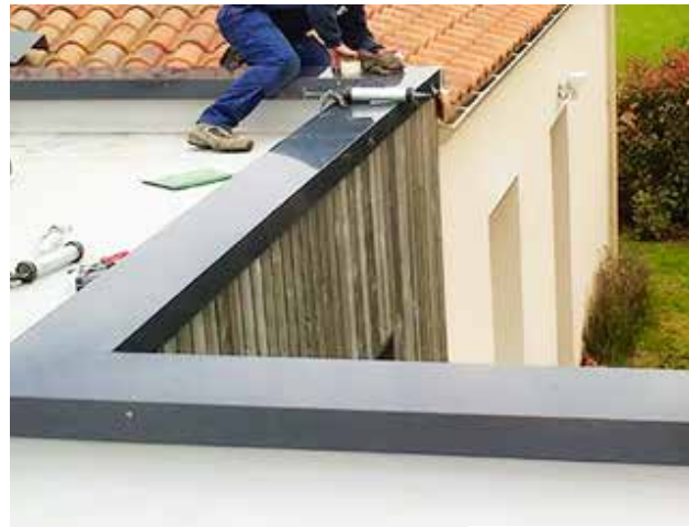
Étanchéité de toit
