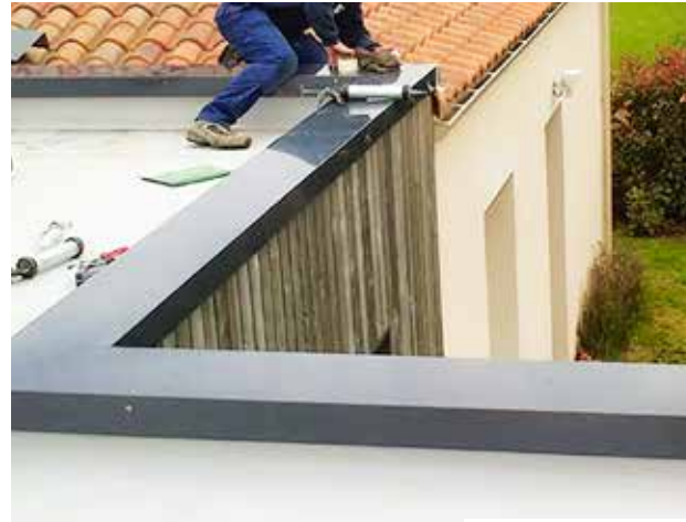
Étanchéité de toit
