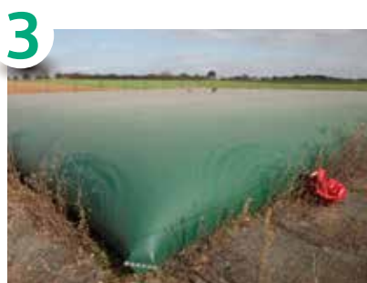
STOCKAGE D'EFFLUENTS AGRICOLES
